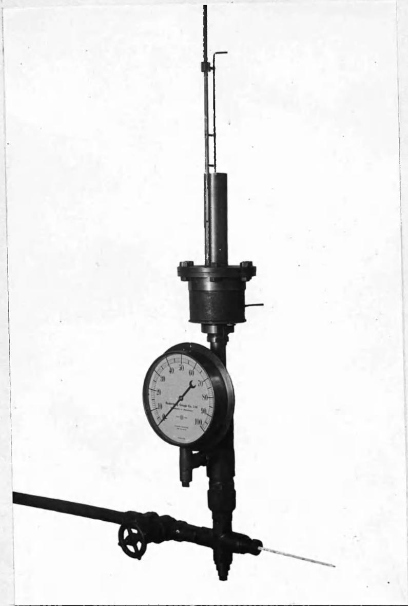
Fig. 3 — Experimental Air Ejector.
