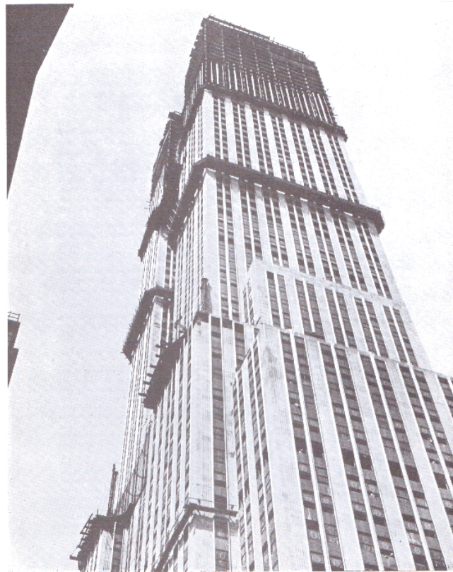
NEW YORK. — L'AMPHITHEATRE ACTUELLEMENT EN CONSTRUCTION, C'EST TOUJOURS LA FIN DU RUE AVENUE S'ENTRE LA 32 ET LA 33 RUE, S'ÉLEVANT PAR HAUTEUR DE QUATRE ÉTAGES.
